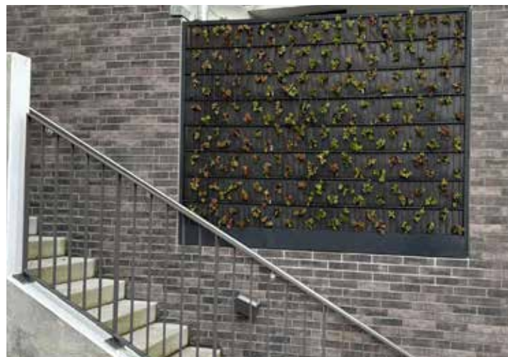
In Fassaden und Wände integrierte Pflanzen-Gabione
