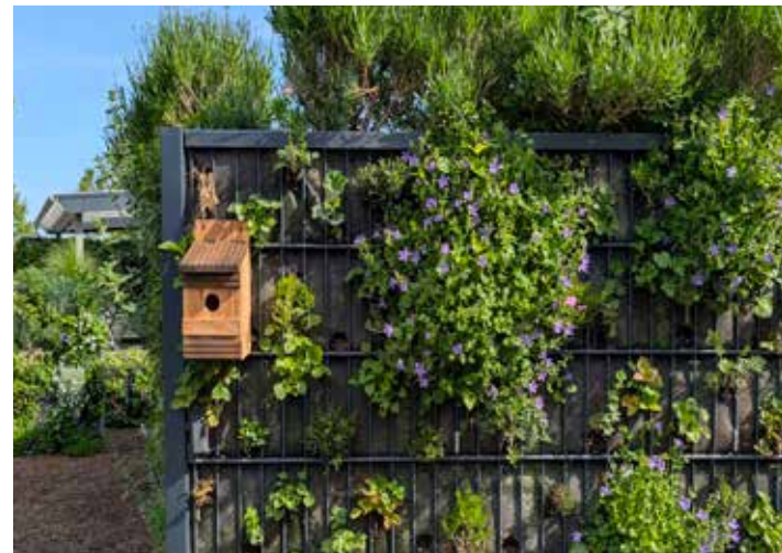
Pflanzen-Gabionen mit integrierten Nisthilfen für Vögel und Insekten / Einbindung von Maulwurf-tunneln
