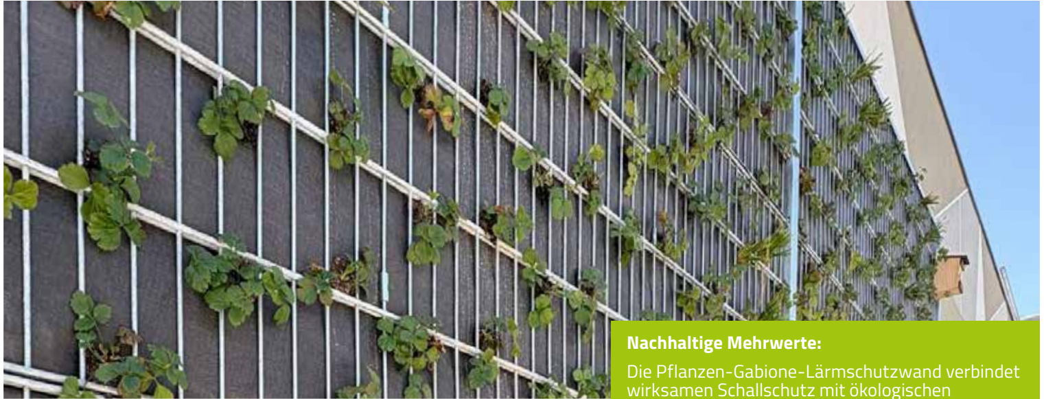
(Pflanzen-Gabione neu bepflanzt)
